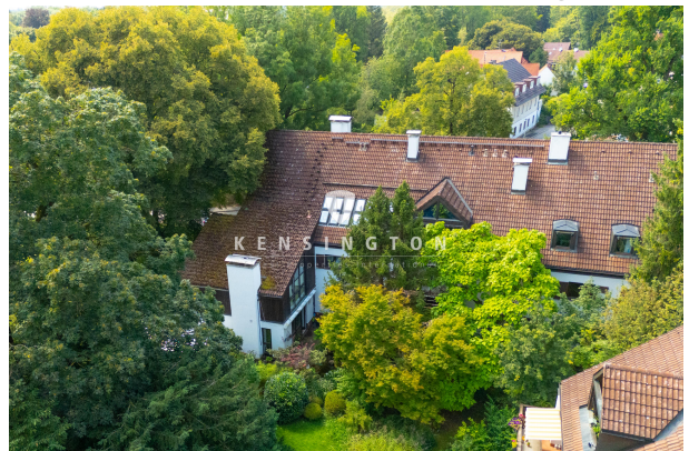
Außenansicht mit Blick in den Gemeinschaftsgarten
